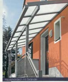
Haustürvordach mit Geländer
