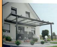
Terrassendach mit persischen Stützen
