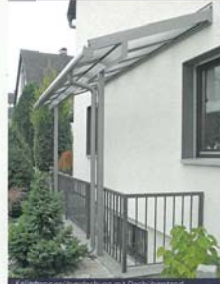
Kellertreppen-Überdachung mit Dachüberhang
