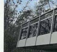
Geländer mit Solarmodulen
