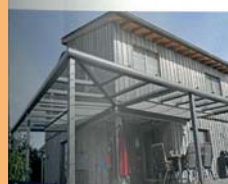
Terrassendach mit Rollschuttluv-Verkleidung
