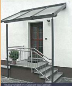
Haustürvordach mit Geländer aus Edelstahl
