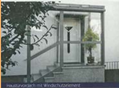
Haustürvordach mit Windschutzelement
