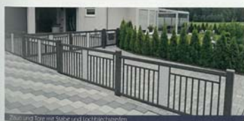
Zaun und Tore mit Stäben und Lochblechplatten
