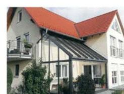
Terrassendach als Dachverlängerung
