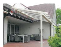
Überdachung auf den Hausdach aufgesetzt
